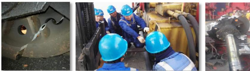
12月的码头现场，平台上寒风瑟瑟，在工程部桥吊主管徐红春的指挥和带领下，诊断后迅速确定了抢修方案，布置落实了安全防范措施，大家“兵分几路”，因故障排除较为复杂，在拆除桥吊电动机、齿轮箱后，需要用500吨千斤顶把桥吊顶起来，便于大车驱动轮的顺利更换，抢修工作有条不紊地进行着。经大半夜的忙碌，当把拆除的最后一个备件装好后，天空已经慢慢地开始发亮了，124#桥吊又投入了运营，成果的喜悦使突击队员忘记了疲惫。
